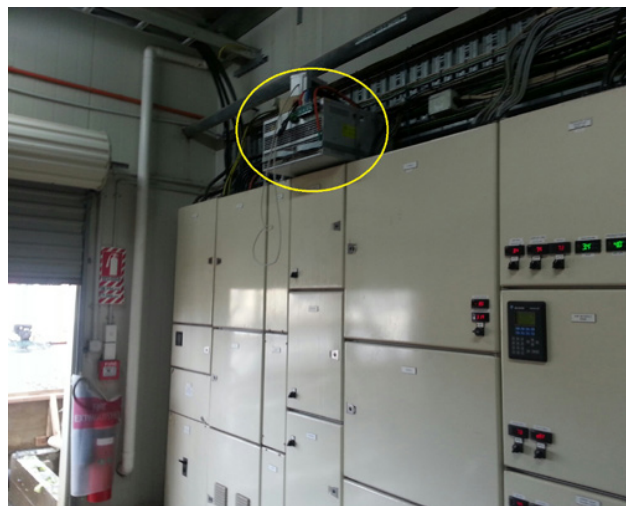
The temporary SVG 100kVAr unit
